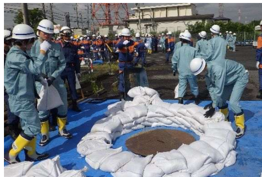
釜段工法で土のうを積む様子
