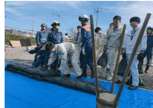
土のう積工法の実施
