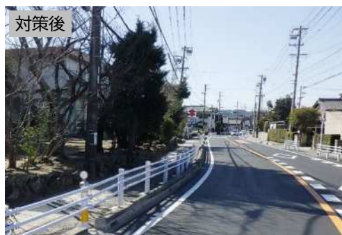
通学路における防護柵設置（県道美合幸田線）
