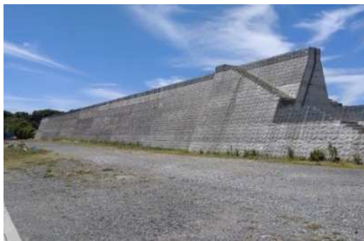
海岸堤防の新設 (赤羽根漁港海岸)
