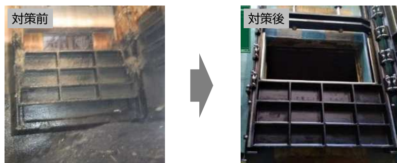
分配槽機械設備の劣化状況と更新工事（下水処理場）
