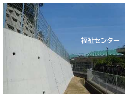
急傾斜地崩壊防止施設（中柴区域）の整備（岡崎市）
