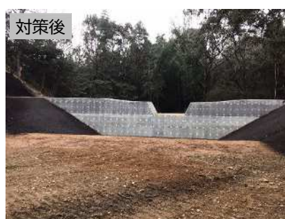
砂防堰堤の改築工事（岩次洞堰堤）（小牧市）
