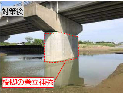
橋梁の耐震補強（県道豊橋渥美線 紙田川橋）
