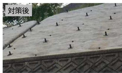
急傾斜地崩壊防止施設の修繕工事（踊山区域）（岡崎市）
