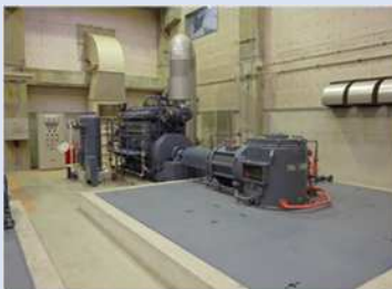
1号主ポンプ設備（エンジン/減速機） （青木川放水路排水機場）
