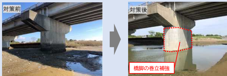
橋梁の耐震補強（県道豊橋渥美線 紙田川橋）
