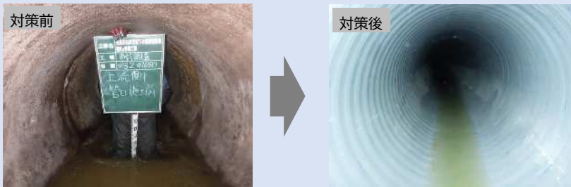
管渠の劣化状況と対策工事（下水管きょ）
