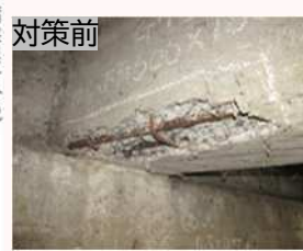
コンクリート桁の補修前
