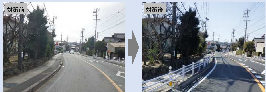
通学路における防護柵設置（県道美合幸田線）
