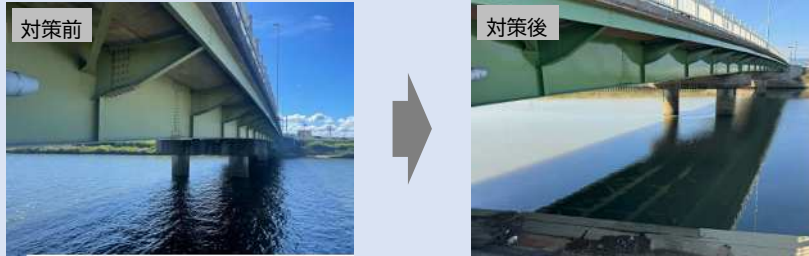
再塗装工事（県道津島名古屋線 新御贄橋（津島市））
