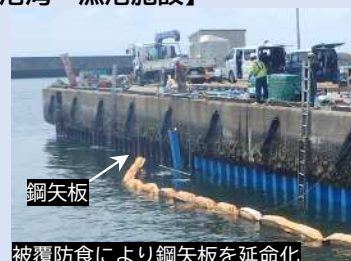
被覆防食により鋼矢板を延命化 物揚場の補修 （西幡豆漁港）
