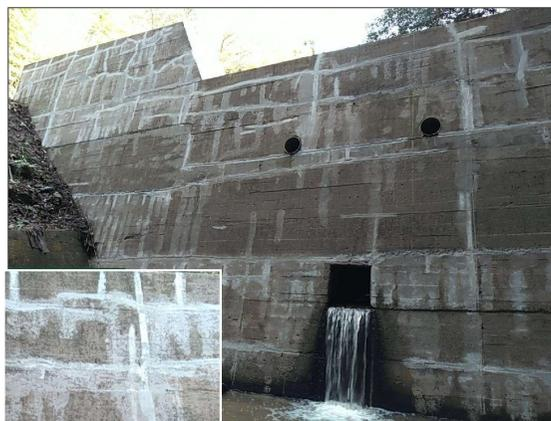
▲小呂川堰堤(岡崎市)の堰堤のひび割れ補修
