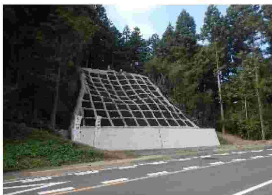
山腹工（新城市）
