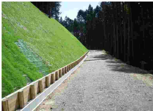
過疎山村地域代行林道事業（開設）西薊目御園線（東栄町）
