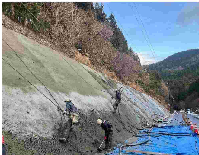
広域農道奥三河地区の整備補修
