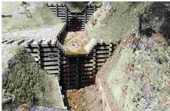
木製床固工（設楽町）
