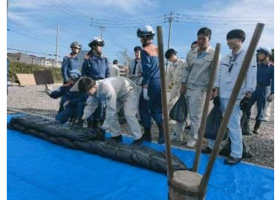
土のう積工法の実施
