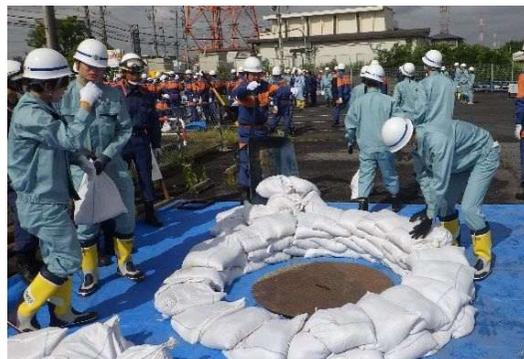
釜段工法で土のうを積む様子
