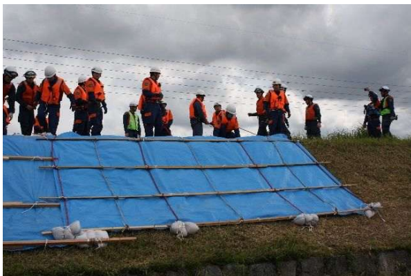
水防工法訓練(梅田川右岸植田橋付近)
