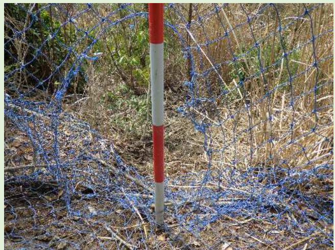
獣害柵の破損状況
