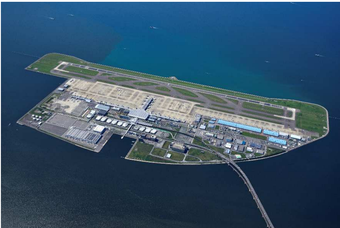
図表 中部国際空港全景
