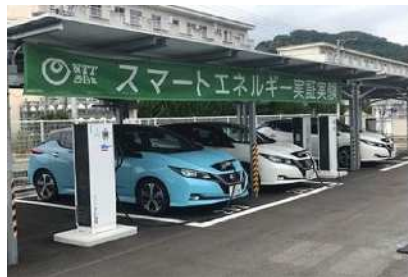
(写真) NTT 西日本 山口支店におけるカーポート PV と V2B の設置状況
