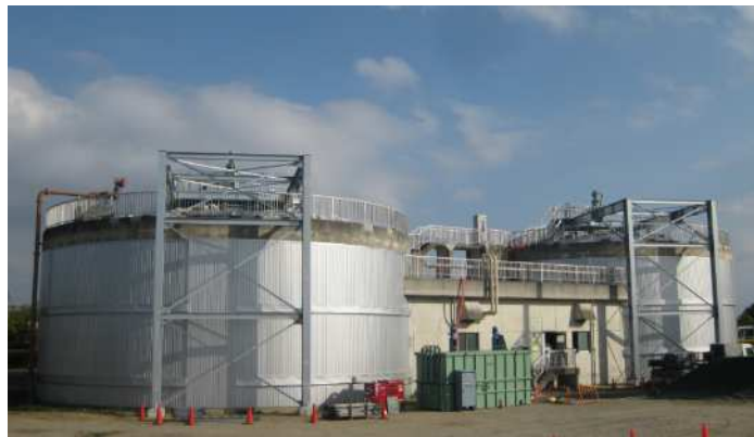
下水汚泥メタン発酵施設
