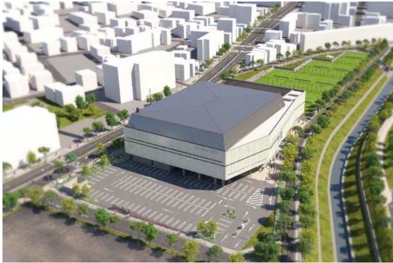
北西上空より
