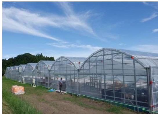
産地生産基盤パワーアップ事業で導入した低コスト耐候性ハウス(新城市)
