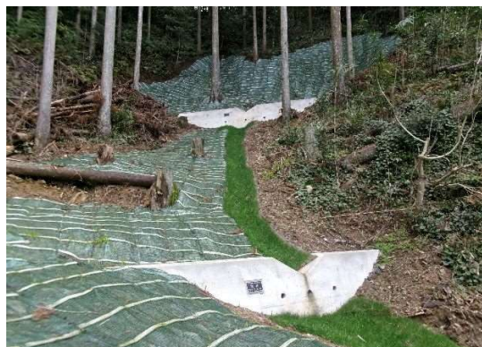
土留工(新城市)
