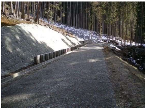
過疎山村地域代行林道事業(開設)中口尤線(設楽町)
