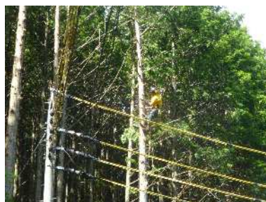
樹上での作業(設楽町)
