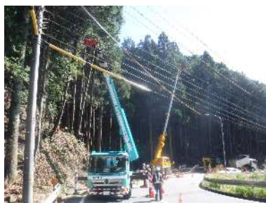
重機を使用した伐採(新城市)
