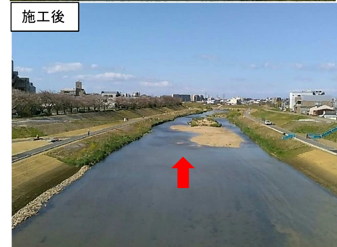
天白緑地橋付近の河道拡幅の様子
