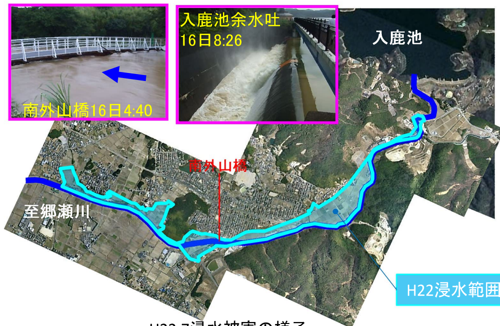
H22.7浸水被害の様子
