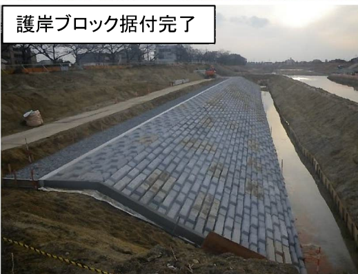
護岸ブロック据付後、表面を覆土
