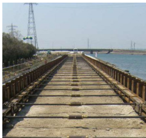
耐震対策実施状況
