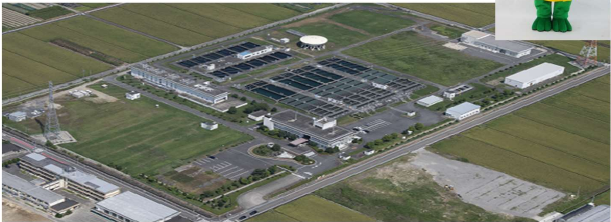
尾張西部浄水場
