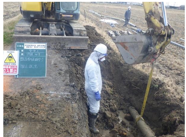
【石綿セメント管の撤去(愛西市)】
