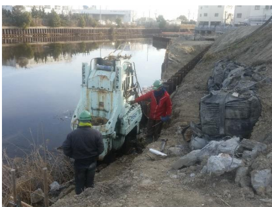
【飛島排水機場の整備（飛島村）】
