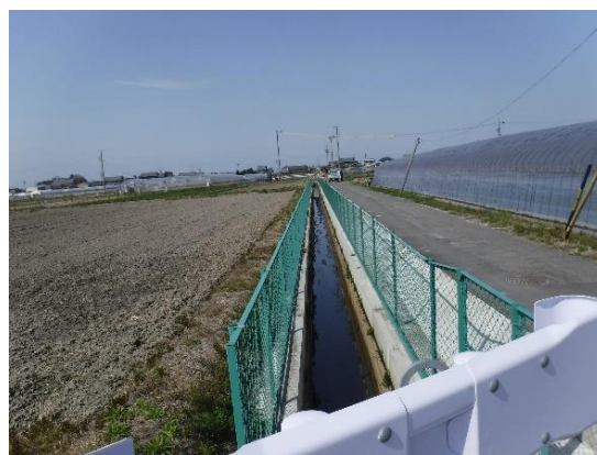
【立田地域の排水路整備（愛西市）】
