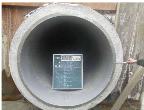
農業用水路の整備(愛西市) 〔地盤沈下対策事業〕
