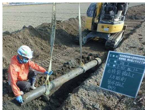
石綿セメント管の撤去(弥富市) 〔特定農業用管水路特別対策事業〕
