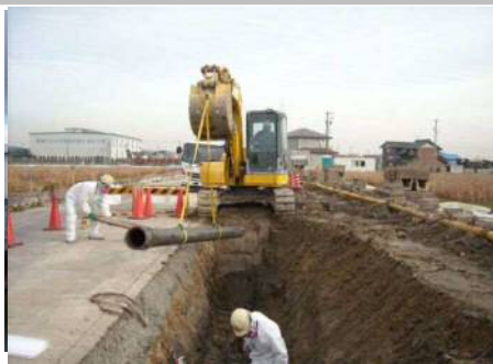
(石棉セメント管撤去状況)
