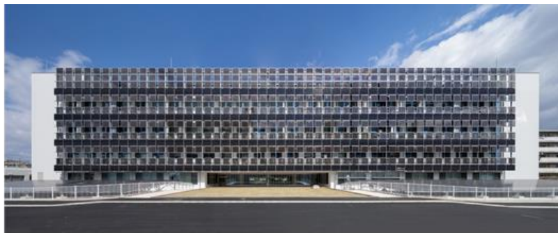
環境調査センター・衛生研究所
