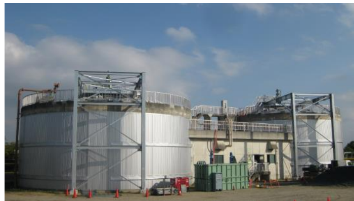
下水汚泥メタン発酵施設
