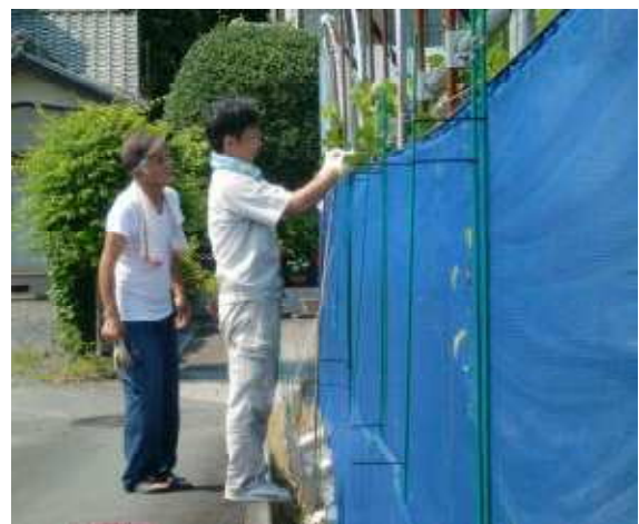
中型獣用侵入防止柵の設置作業 (H30 新城市)
