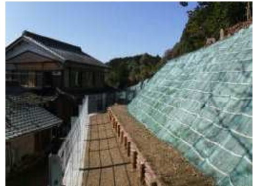
平成30年度土留工、植生マット 施工地（H31.3.5 新城市長篠）
