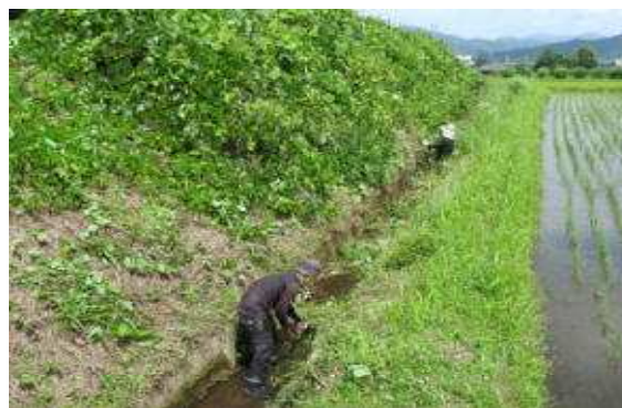
交付金を活用した水路整備（新城市）
