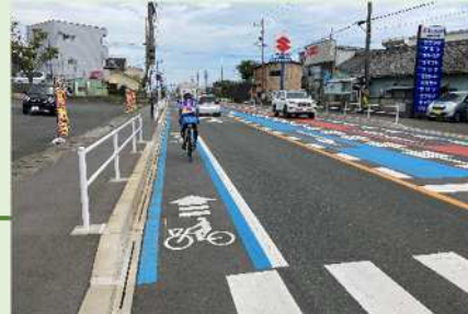
▲主要地方道豊橋湖西線(豊橋市)
