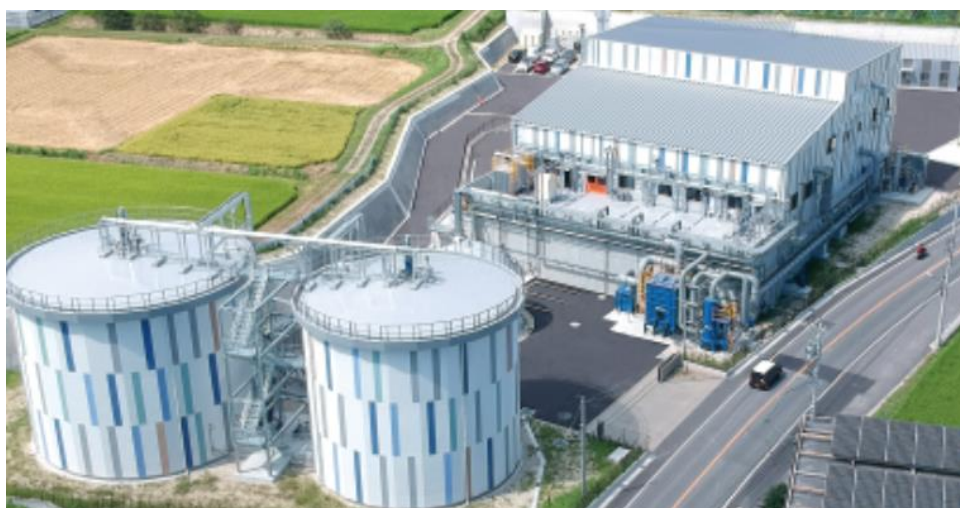
バイオマス利活用施設
