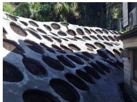
植生基材の吹付による早期緑化の促進 (南知多町 篠島地区)
