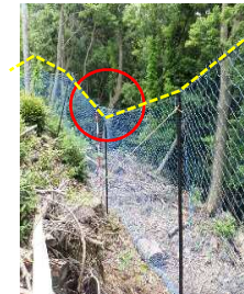
設置ラインの凹地
