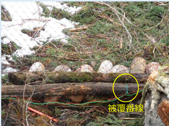
③沢の向きと直角に丸太を敷き、被覆番線等で押えロープと固定する
