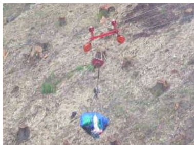
架線を用いた資材運搬
