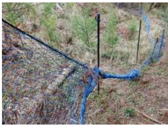
動物の絡まりによる破損
