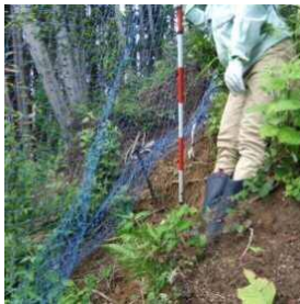
▲アンカー杭が外れ、大きく開いた隙間
