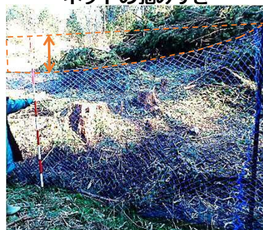
下はOK、高さが足りない
