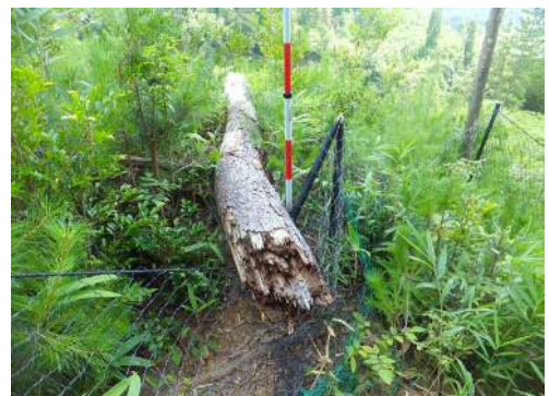
倒木によるネットの破損
