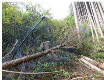
倒木による破損
