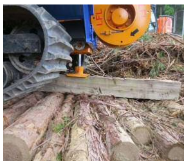
タワーヤード センターリガーの設置
