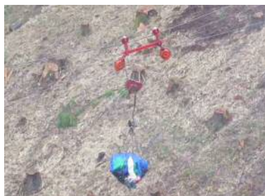
架線を用いた資材運搬
