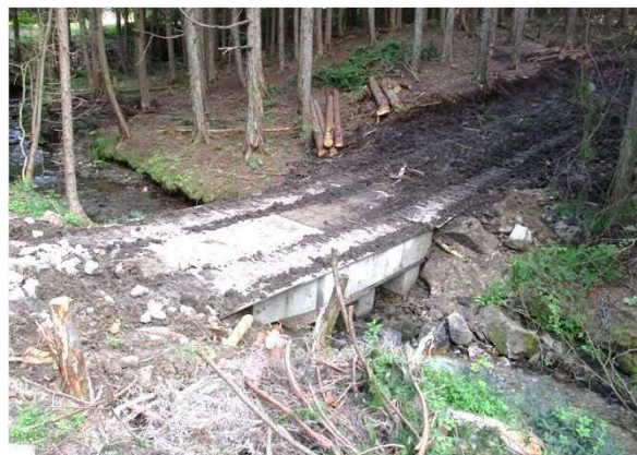
コンクリートブロックによる仮設橋
