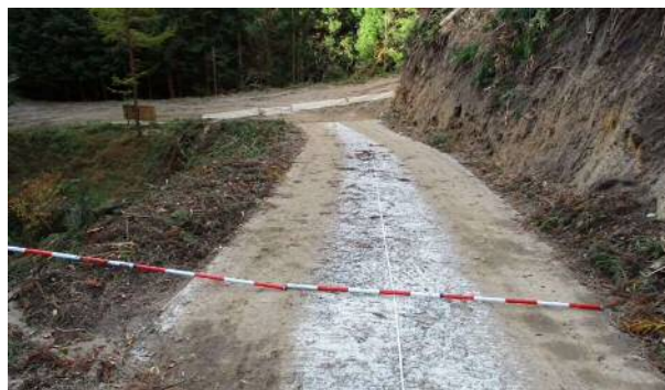
コンクリート滑り止め
