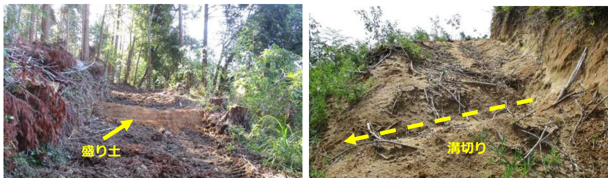
作業終了後の排水処理を施した森林作業道
