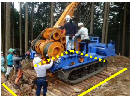
タワーヤード 丸太敷きの上での設置作業
