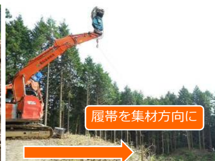
スイングヤードの設置
