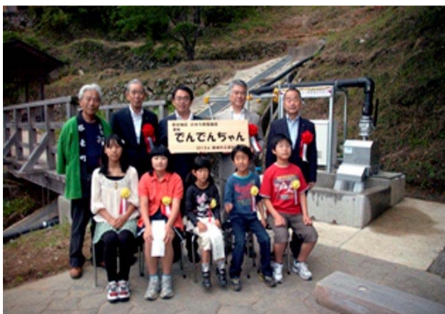
小水力発電（新城市四谷地区）
