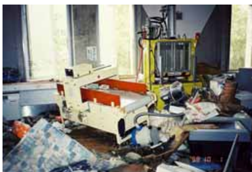
図表 4-4-6 施設内の損傷した設備
