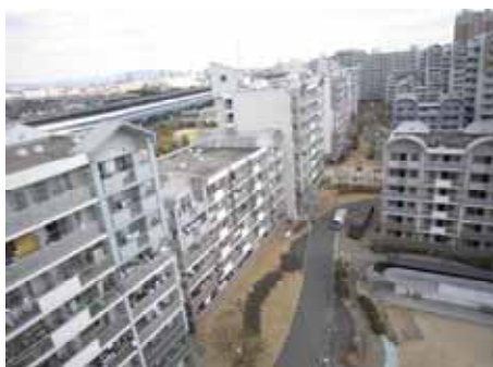
復興公営住宅 (当時、潮芦屋地区には この団地しかなかった)
