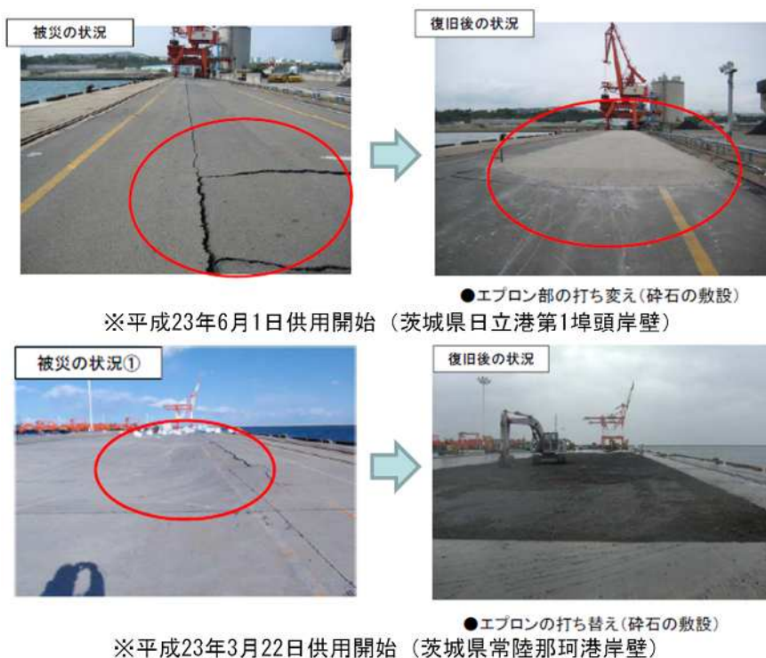
図-5 【参考写真】岸壁・エプロンの応急復旧事例 (東日本大震災)
