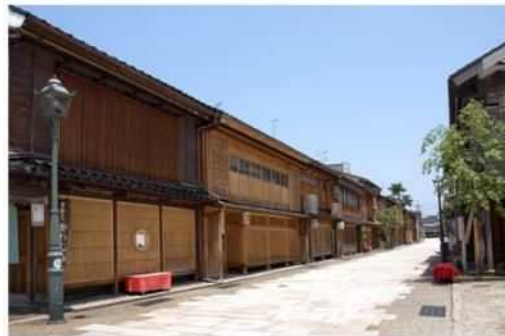
※看板で目隠しを行い、景観に配慮
