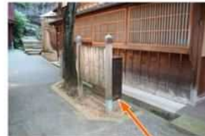
景観に配慮し、看板の後ろに地上機器を設置
