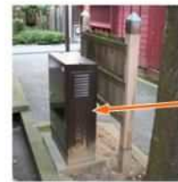
景観に配慮し、看板の後ろに地上機器を設置
