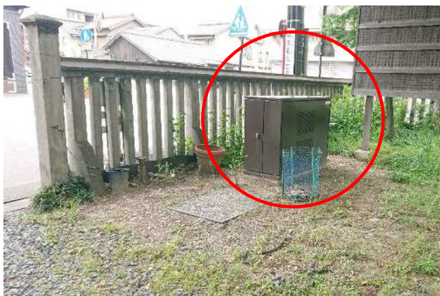
図 3-6 地上機器の民地等への設置事例
