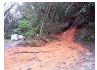
山腹斜面崩落
