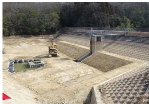
防災ダム事業(伊保新池地区)耐震工事
