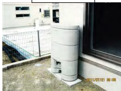
雨水貯留浸透施設
