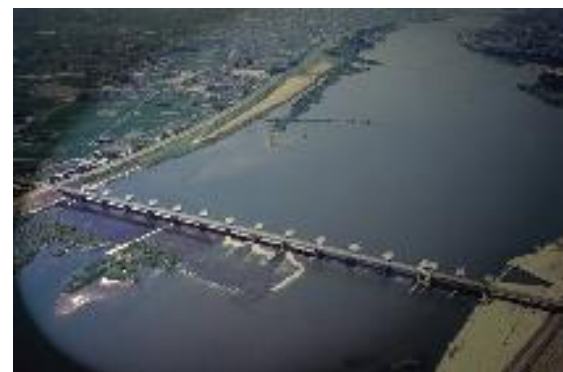
木曾川用水取水口（木曾川大堰）
