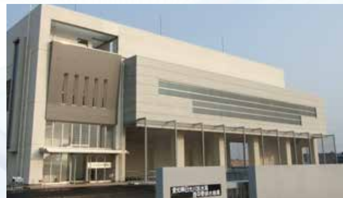
排水機場の例(写真:西中野排水機) 出典:愛知県海部建設事務所
