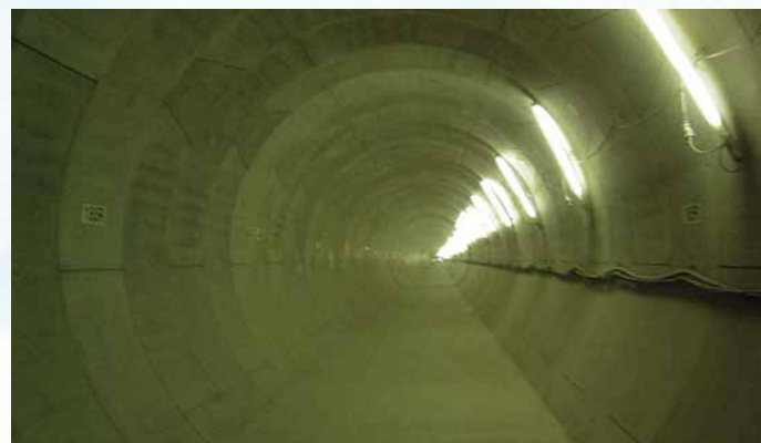
地下トンネルの例(写真:青木川放水路) 出典:愛知県一宮建設事務所
