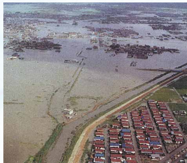
昭和51年豪雨による目比川破堤浸水状況
