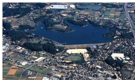
耐震対策を行う三好池(みよし市)
