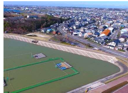
耐震整備が完了した保田ヶ池(みよし市)
