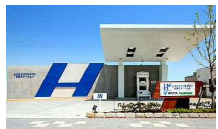
とよたエコフルタウン水素ステーション
