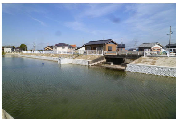
耐震対策を実施した東郷長池（東郷町）
