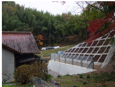
土留工（犬山市）
