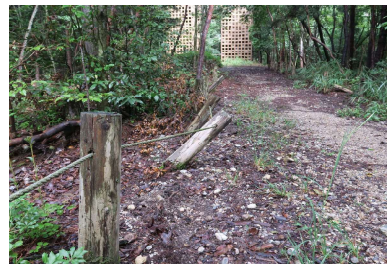
写真3 柵の腐朽
