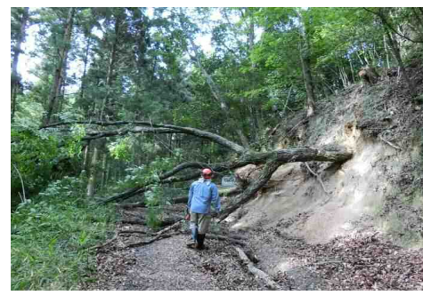
写真10 危険木の除去
