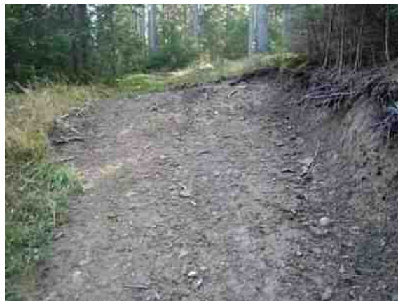
ハーベスタの林道から上がり口の造成 地山の土質は本県と変らない印象
