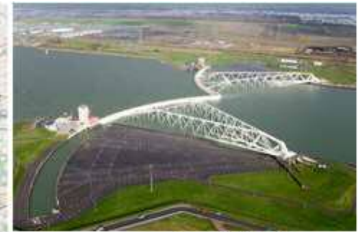
マエスラント可動締切堤
