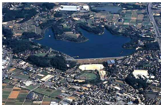
耐震対策を行う三好池(みよし市)
