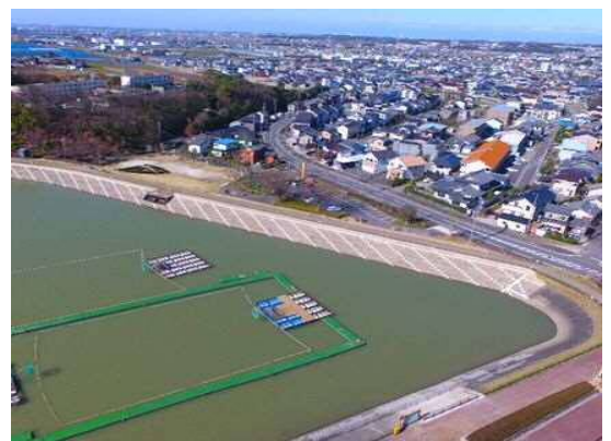
耐震整備が完了した保田ヶ池(みよし市)
