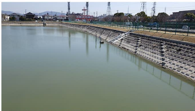
耐震対策を実施した雨池（尾張旭市）
