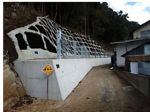
土留工の整備状況（瀬戸市）
