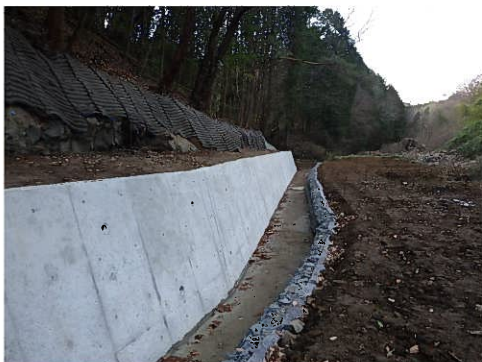
護岸工の整備状況（犬山市）
