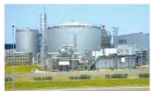
供給プラント
