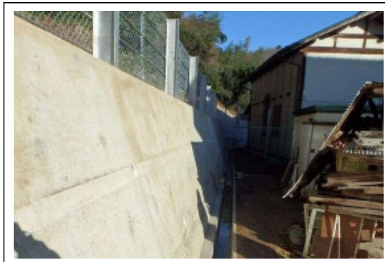
土留工の施工箇所
