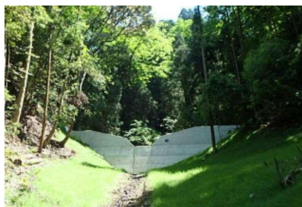
谷止工の施行箇所
