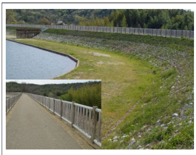
水環境整備事業 岩藤新池1期地区
