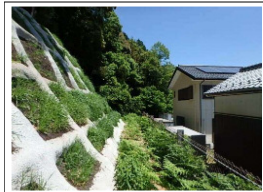
法枠工の施工箇所
