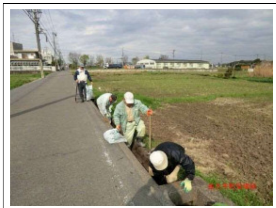
農業用排水路の泥上げ
