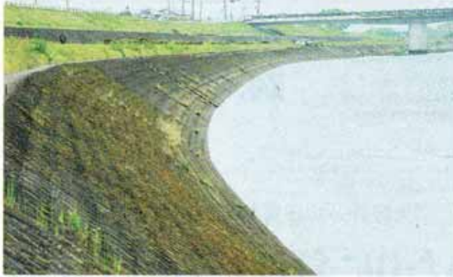
球磨川河口のコンクリート護岸 =16日、八代市(横井誠)
