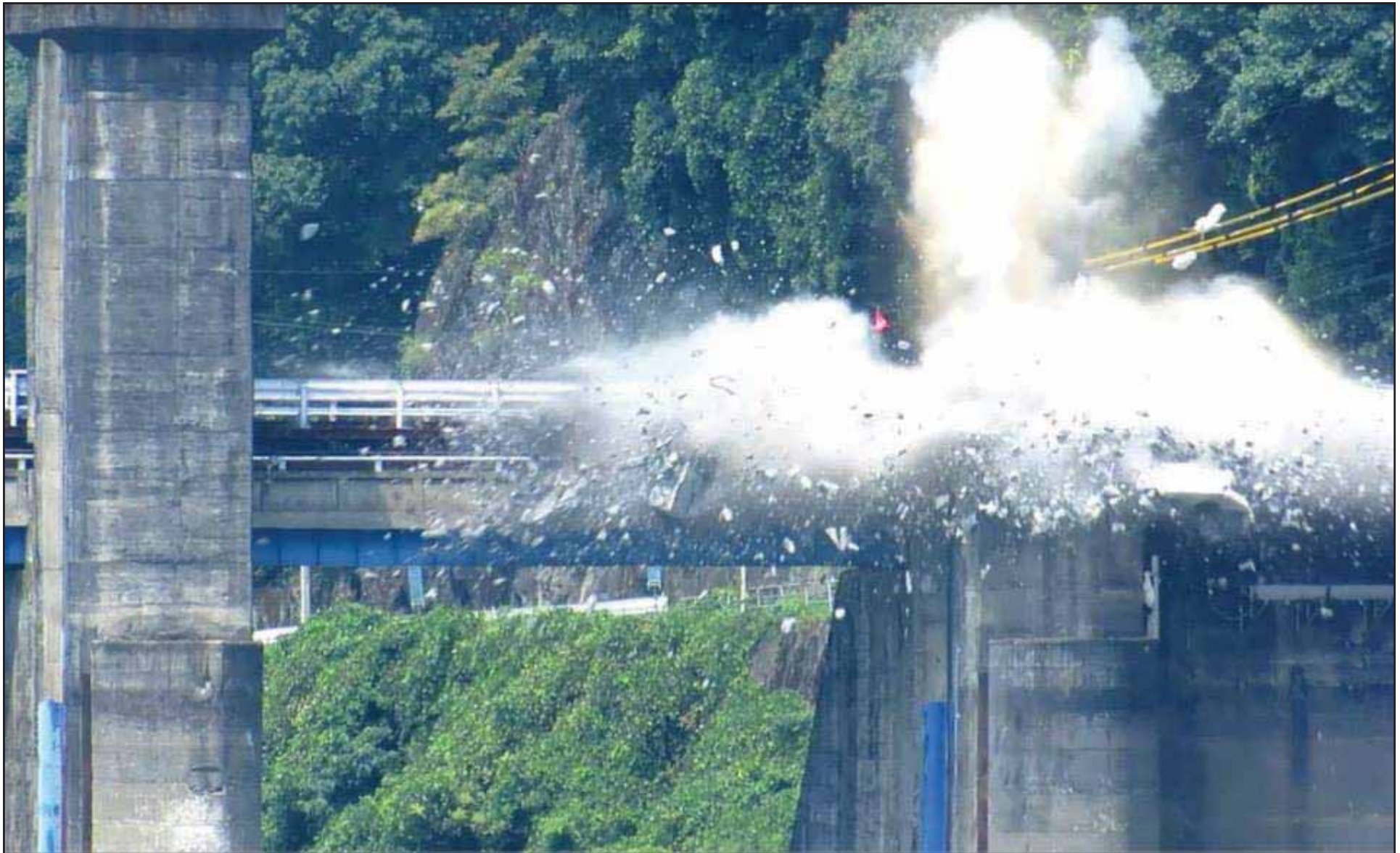
門柱の上部、試験発破
